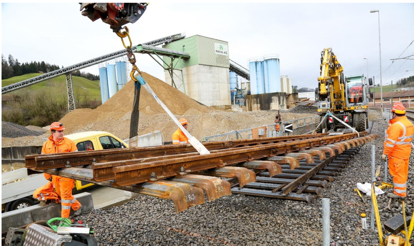
Die Gleisbauer der C. Vanoli AG beim Einbau der neuen Weiche.
